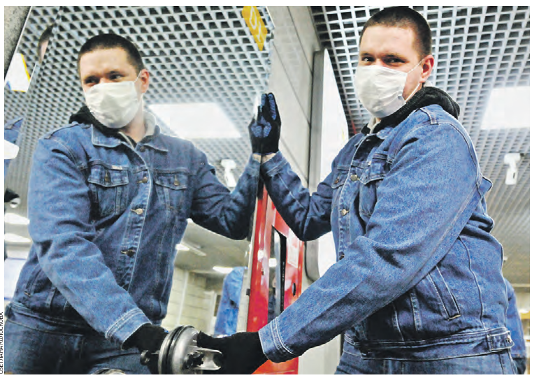
23 марта 10:24 Рабочий-монтажник Александр Новоселов устанавливает зеркало для пассажиров станции «Славянский бульвар» МЦД-1
