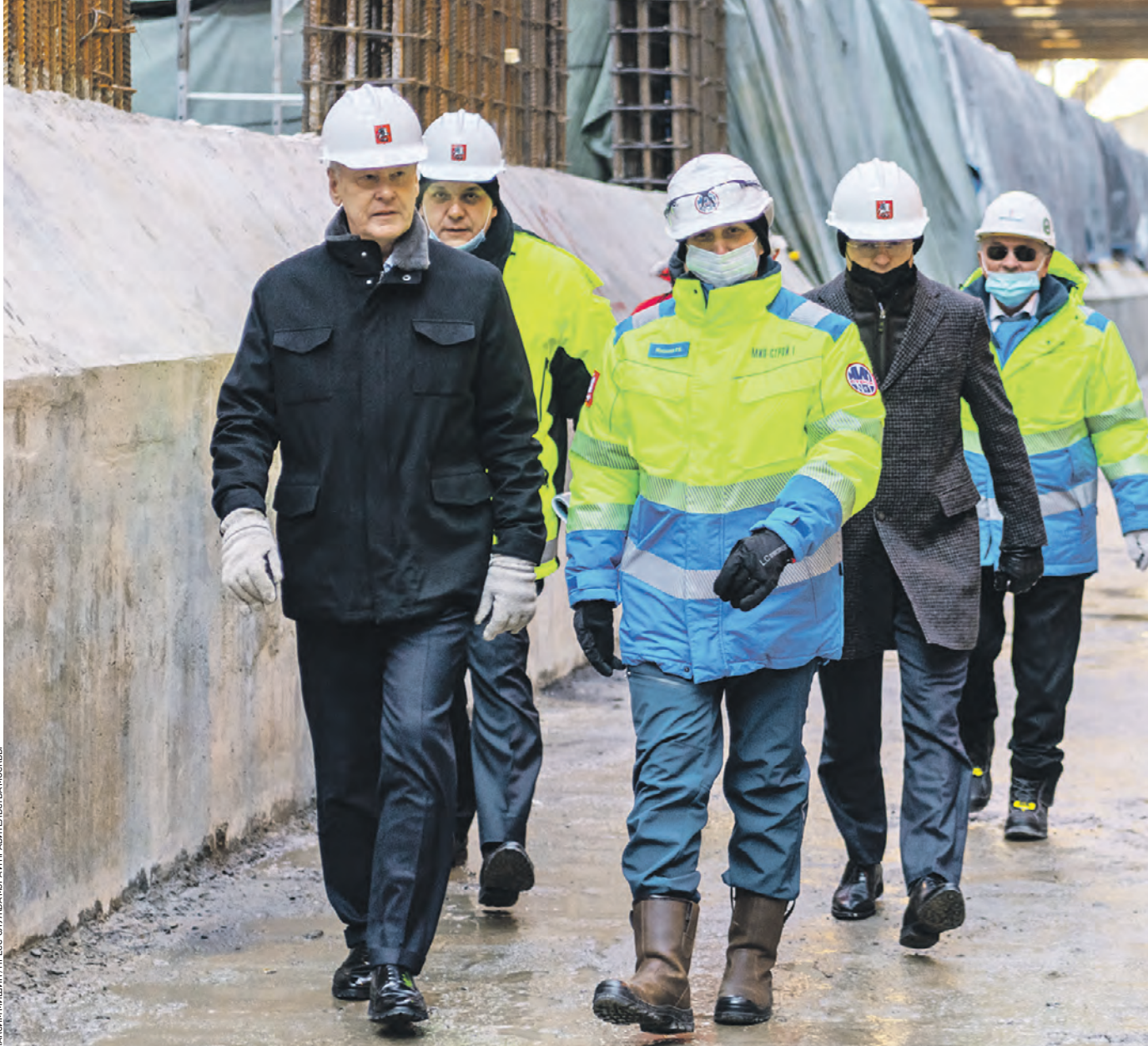
Вчера 14:24 Мэр Москвы Сергей Собянин (слева) и генеральный директор строительной компании Константин Маслаков (справа) осмотрели ход работ на восточном участке Большого кольца. Вчера был дан старт щиту «Лилия» — механизированный комплекс соединит станции «Нагатинский Затон» и «Кленовый бульвар»
