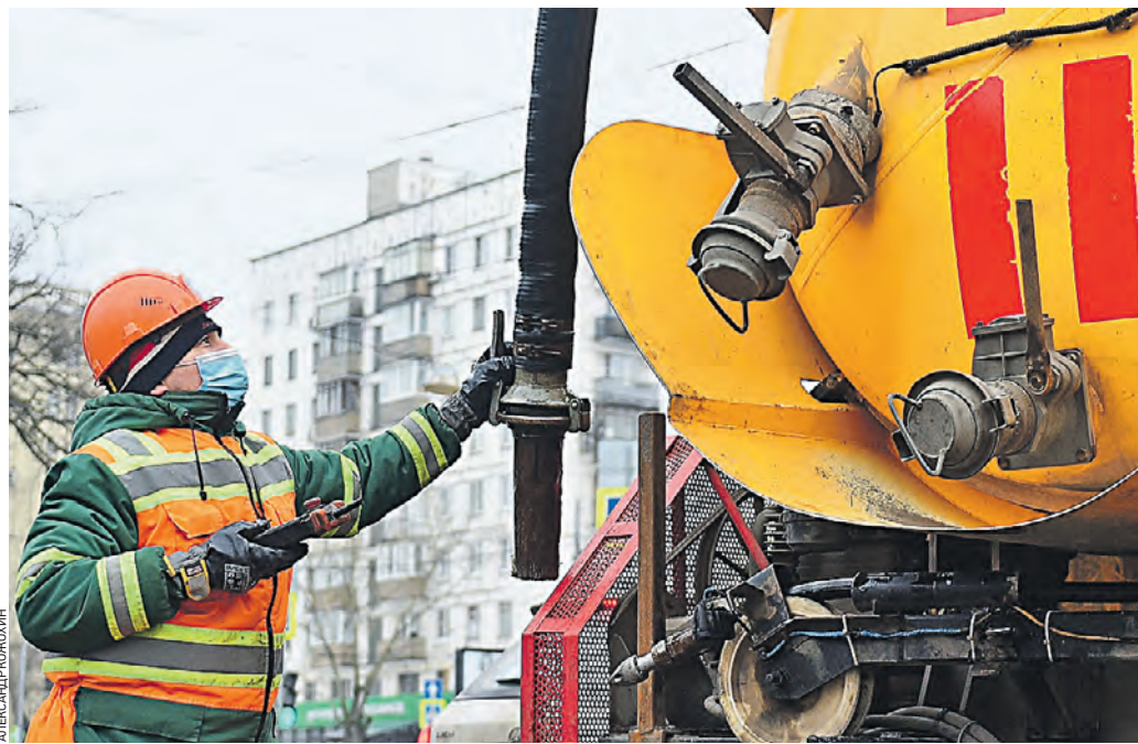
Вчера 10:41 Специалист Мосводостока Александр Фленов управляет рукавом насоса и готовится к очистке водоприемного колодца
