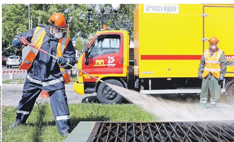
Вчера 10:34 Сотрудники Москоллектора проводят очередную промывку и обработку комплекса городского хозяйства столицы с помощью специальной техники и дезинфицирующих средств на Дорожной улице в Южном округе Москвы. Такая профилактика проводится ежедневно
