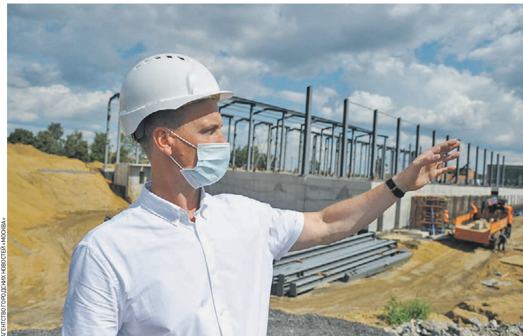
Вчера 11:51 Заместитель директора, главный инженер Люберецких очистных сооружений Максим Курако на строительной площадке новых корпусов механической очистки сточных вод
