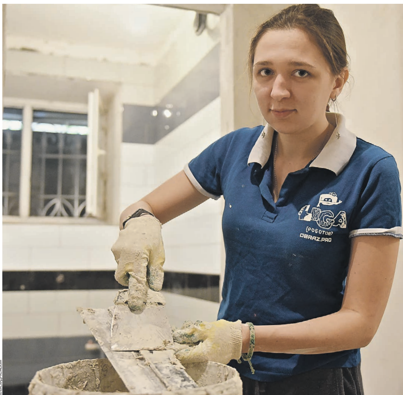
15 июня 16:23 Участница стройотряда, студентка МГТУ имени Баумана Мария Синдская участвует в отделочных работах, ведущихся в помещениях ее родного университета
