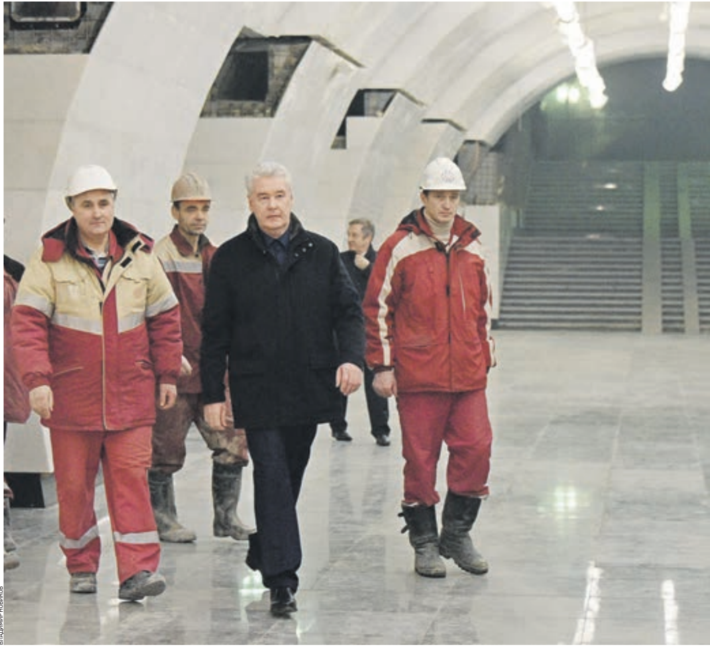
Вчера 11:34 Мэр Москвы Сергей Собянин (в центре) вместе с сотрудниками Мосметростроя (слева направо) Евгением Коробовым, Сергеем Меркуловым и Олегом Мельниковым осматривали строящуюся станцию «Кружневая» на салятовой ветке
