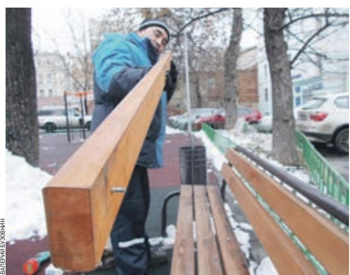
18 декабря 14:52 Плотник Алик Ибрагимов проверяет, прямой ли брус, предназначенный для скамейки на Фрунзенской улице
