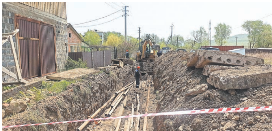
К отопительному сезону 2023-2024 годов планируется заменить 800 метров теплотрассы.
