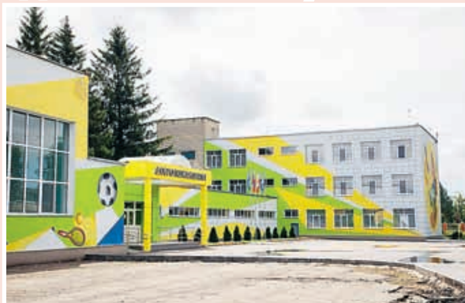
Пристройка дала Татищевскому лицей 240 дополнительных ученических мест.
