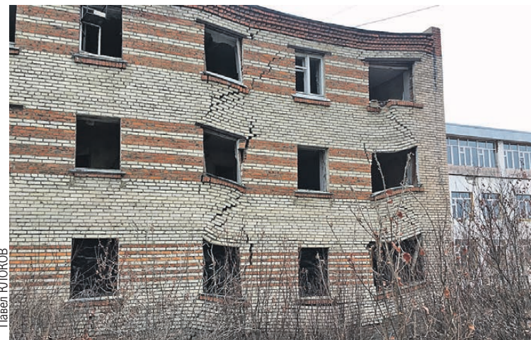
Таковы последствия глобального потепления. Несколько лет назад этот дом в поселке Черский был жилым. Но оттаявшая почва просела, и он начал складываться как гармошка.
