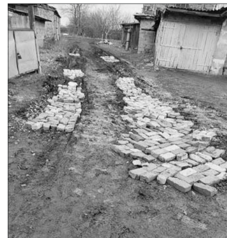
Кирпич шахтинцы взяли в заброшенных зданиях под снос.
