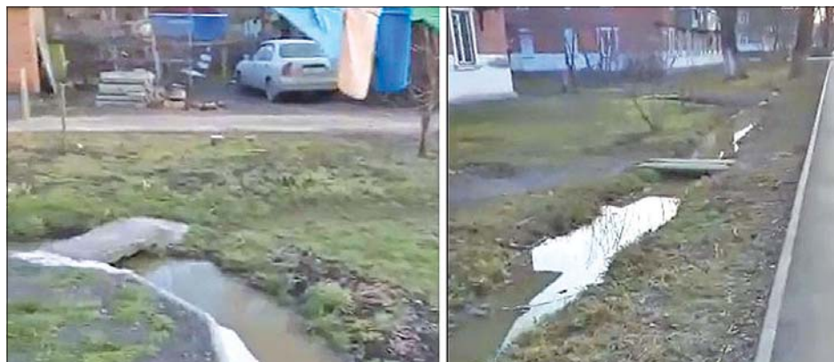
По проспекту Ленинского Комсомола текут нечистоты.
