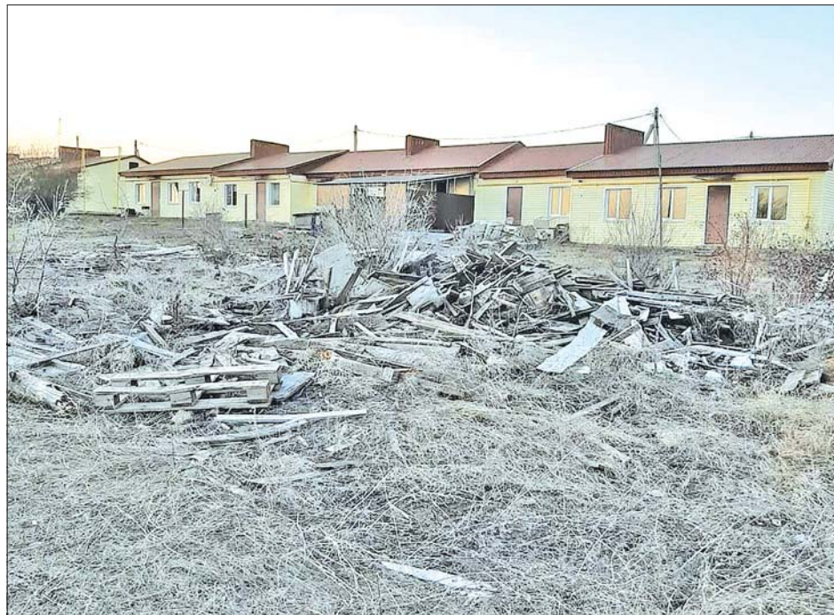
Улица Антрацитовая завалена строительным мусором.
