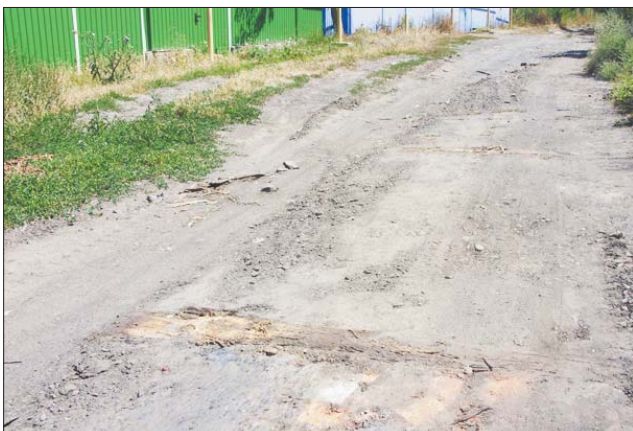
Под ногами сквозь угольную пыль проглядывают железнодорожная насыпь и шпалы.
